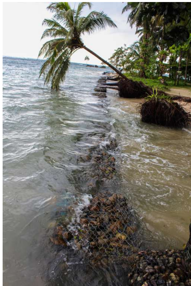
Figura 34. Región Caribe Occidental. Isla Zapatilla, Bocas del Toro. Se observa la colocación de gaveones para contener la constante entrada del mar.
